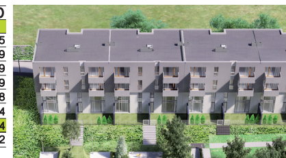
OSIEDLE SZAFIOWE, SUCHY LAS
