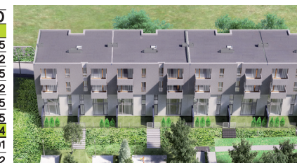
OSIEDLE SZAFIOWE, SUCHY LAS
