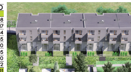
OSIEDLE SZAFIOWE, SUCHY LAS
